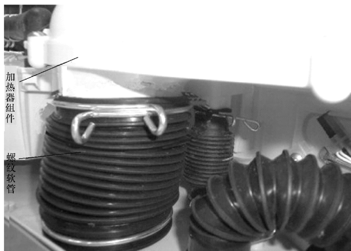
图 3-35 拆卸与加热器连接的螺纹管
