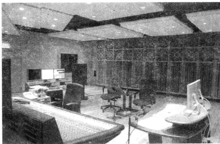
图 1-25 录音棚控制室内后墙安装的扩散体
