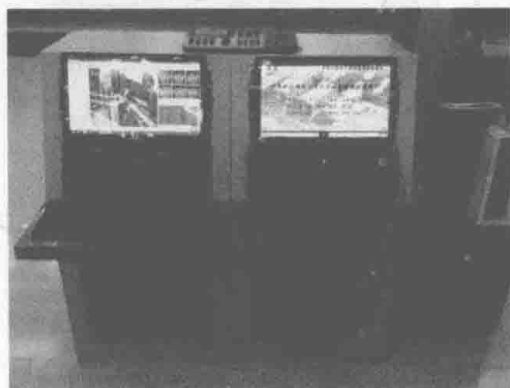
图6-7 视频监控系统控制台和大屏幕
