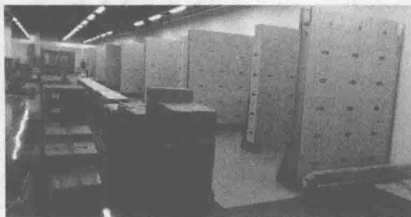
图7-9 安装现场照片
