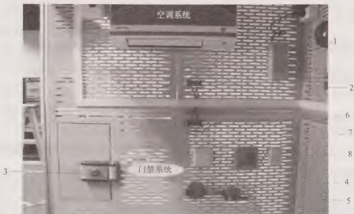
图5-39 门禁系统硬件安装效果图
